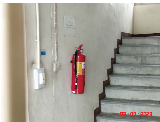
เครื่องดับเพลิงเคมีชนิดมือถือ
