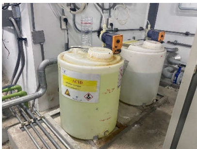
ระบบเติมสารเคมีฆ่าเชื้อ
