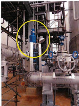
ภาพที่ 2.2-29 อุปกรณ์ระบายความดันของถังเก็บ ผลิตภัณฑ์ (PSV)
