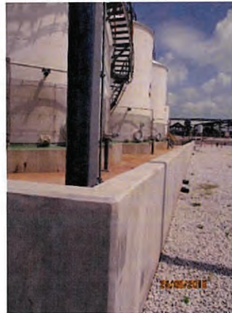
ภาพที่ 2.2-28 เขื่อนกั้นบริเวณถังสารเคมีและ ถังผลิตภัณฑ์
