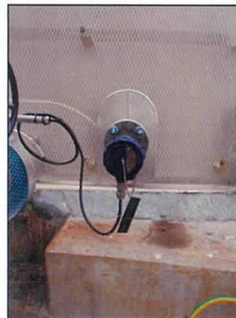
ภาพที่ 2.2-35 อุปกรณ์ตรวจวัดอุณหภูมิของถังผลิตภัณฑ์
