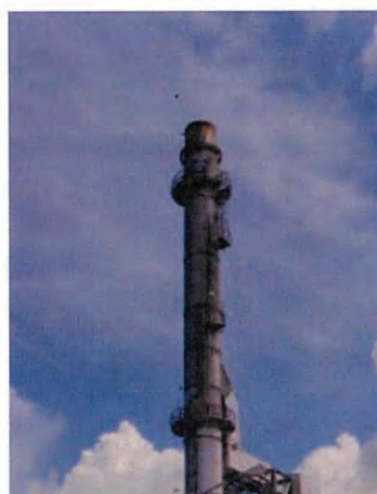
ภาพที่ 2.2-2 หน่วยทำลายก๊าซและของเหลวที่เหลือจากการผลิต (TOX) ในความรับผิดชอบของ บริษัท ดาว เคมิคอล จำกัด (เดิม HPPO)
