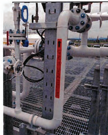
ภาพที่ 2.2-30 ท่อส่งไนโตรเจนเข้า Pad ถังเก็บกัก
