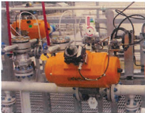
ภาพที่ 2.2-33 ระบบ Automatic Block Valve ของ PO
