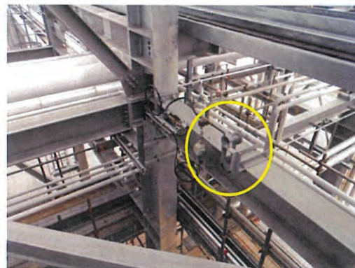
ภาพที่ 2.2-24 อุปกรณ์แจ้งเหตุหรือสัญญาณเตือนภัย
