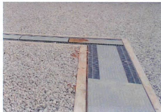
ภาพที่ 2.2-6 รางระบายน้ำในพื้นที่ก่อนลงสู่บ่อหน่วงน้ำ
