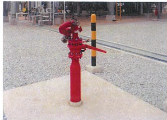
ภาพที่ 2.2-22 Fire Monitor Gun
