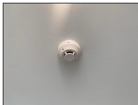
รูปที่ 29 เครื่องตรวจจับความร้อนภายในอาคาร
