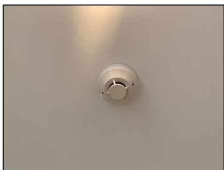
รูปที่ 29 เครื่องตรวจจับความร้อนภายในอาคาร
