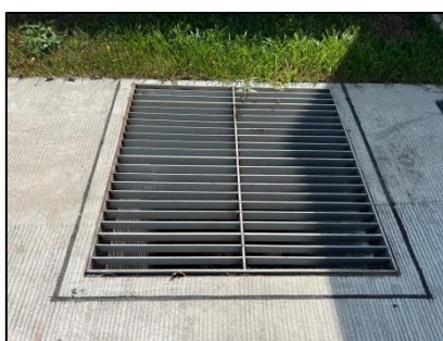
รูปที่ 26 ตะแกรงครอบท่อและรางระบายน้ำ
