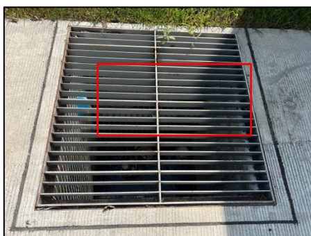
รูปที่ 14 ตะแกรงคัดขยะ
