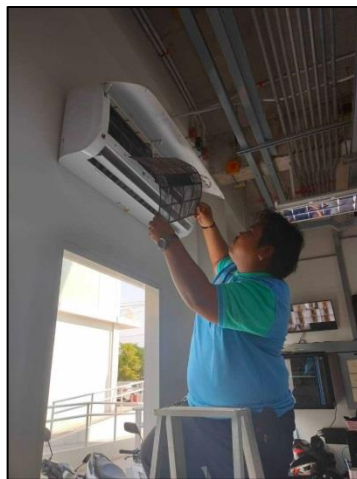
รูปที่ 41 พนักงานทำความสะอาดเครื่องปรับอากาศ
