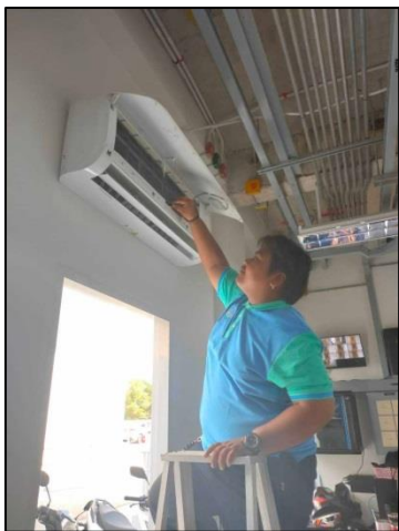
รูปที่ 41 พนักงานทำความสะอาดเครื่องปรับอากาศ
