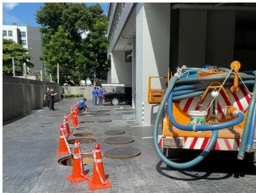
ให้รถเข้ามาสูบน้ำและตะกอนส่วนเกิน
