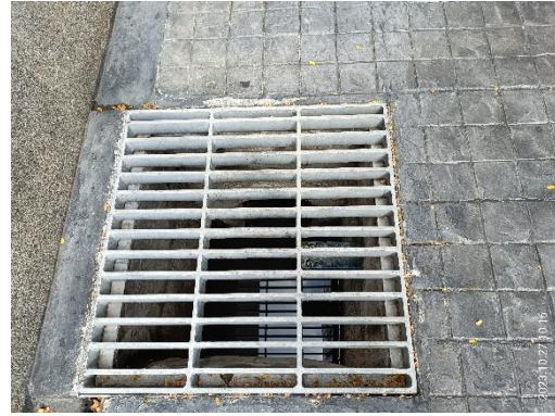
รางรับน้ำฝนเข้าสู่บ่อหน่วงน้ำฝนภายในโครงการ
