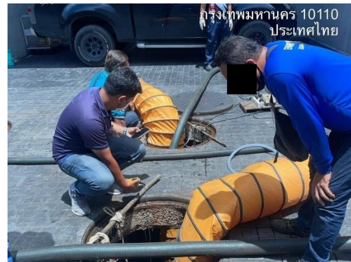
ให้รถเข้ามาสูบน้ำและตะกอนส่วนเกิน
