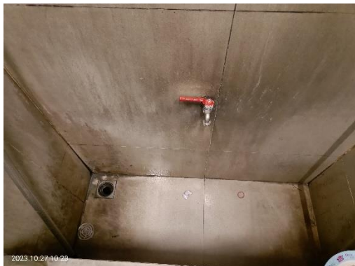
ท่อรวบรวมน้ำเสียที่เกิดจากการล้างห้องพักลอยรวม
