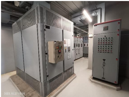
Transformer ชนิด Dry type ขนาด 1,600 KVA จำนวน 2 ชุด
