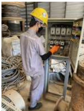
รูปที่ 37 พนักงานสวมใส่อุปกรณ์คุ้มครองความปลอดภัยส่วนบุคคลสำหรับงานไฟฟ้า
