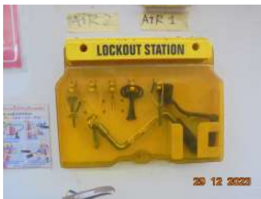
รูปที่ 31 อุปกรณ์ระบบ Log out-Tag out
