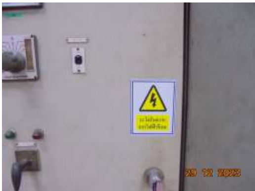
รูปที่ 36 ป้ายเตือนอันตรายบริเวณที่อาจเกิดอันตรายจากกระแสไฟฟ้า
