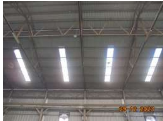
รูปที่ 35 การติดตั้งไฟฟ้าส่องสว่าง
