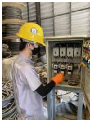
รูปที่ 37 พนักงานสวมใส่อุปกรณ์คุ้มครองความปลอดภัยส่วนบุคคลสำหรับงานไฟฟ้า
