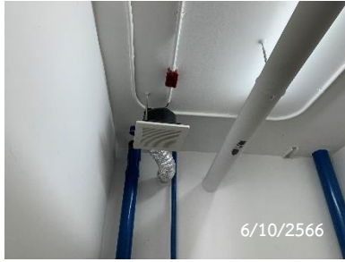
พัดลมระบายอากาศในห้องพักมูลฝอย
