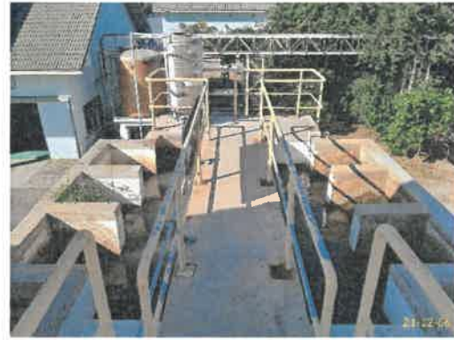
ระบบสร้างตะกอน
