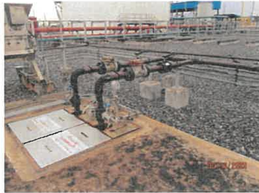
ภาพที่ 2.2-10 บ่อตรวจสอบคุณภาพน้ำทิ้ง พร้อมมวลลว ของโรงไฟฟ้า
