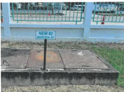
ภาพที่ 2.2-4 Inspection Manhole โรงงาน
