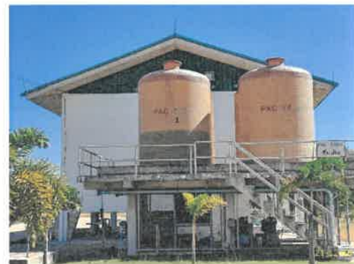
ระบบสร้างตะกอน
