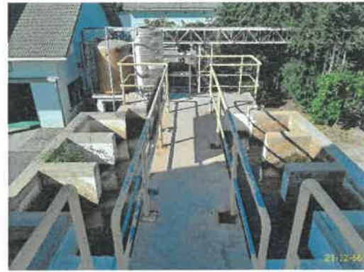
ระบบสร้างตะกอน
