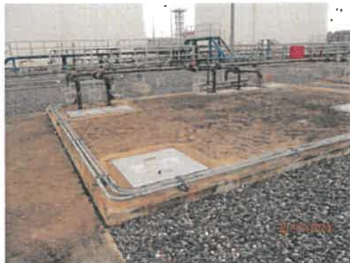
ภาพที่ 2.2-10 บ่อตรวจสอบคุณภาพน้ำทิ้ง พร้อมมวลลว ของโรงไฟฟ้า
