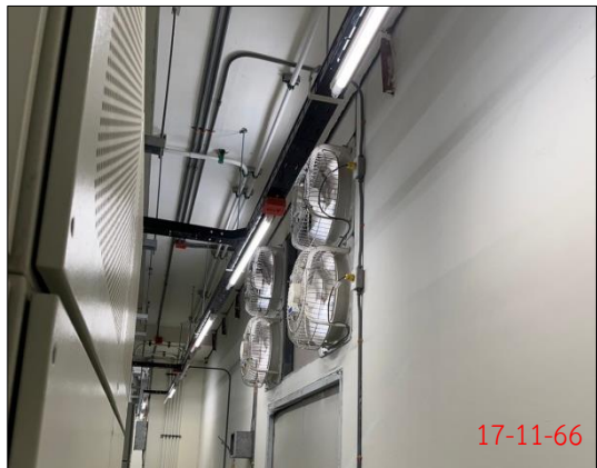
พัฒนาระบายอากาศในห้องควบคุมไฟฟ้า
