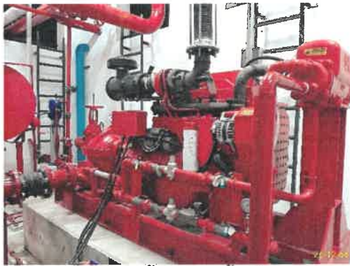
เครื่องสูบน้ำดับเพลิงชั้นใต้ดิน
