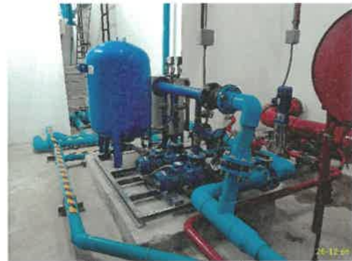
ปั๊มน้ำใช้อุปโภค-บริโภค ชั้นตาดฟ้า
