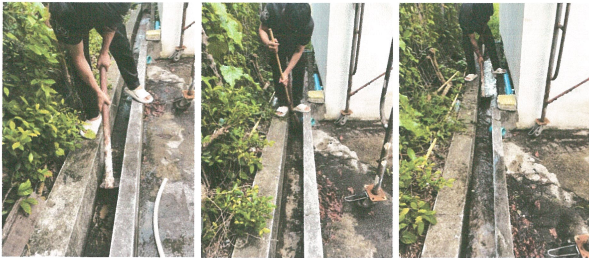
รูปภาพที่ 2.8 การขุดลอกตะกอน
