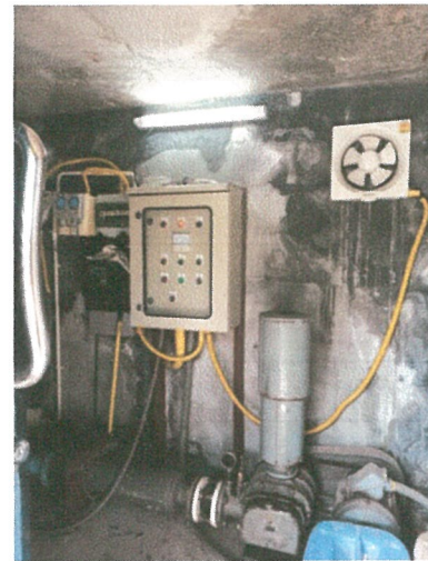
รูปภาพที่ 2.35 เครื่องเติมอากาศระบบบำบัดน้ำเสีย
