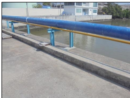
รูปที่ 5 ขอบคอนกรีตสูง 10 เซนติเมตร รอบพื้นที่ทำเรือ
