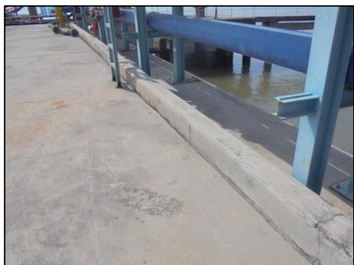
รูปที่ 5 ขอบคอนกรีตสูง 10 เซนติเมตร รอบพื้นที่ทำเรือ
