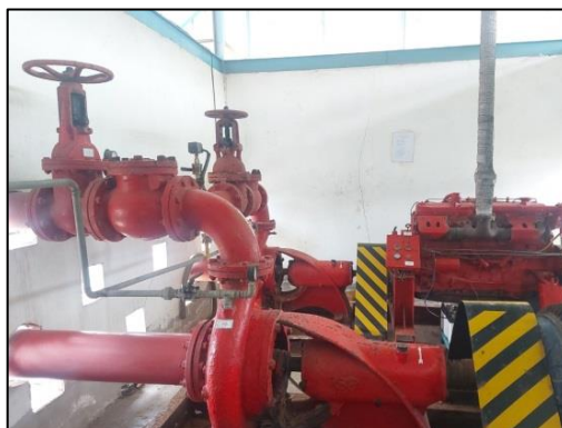
รูปที่ 14 ปั้มน้ำดับเพลิง
