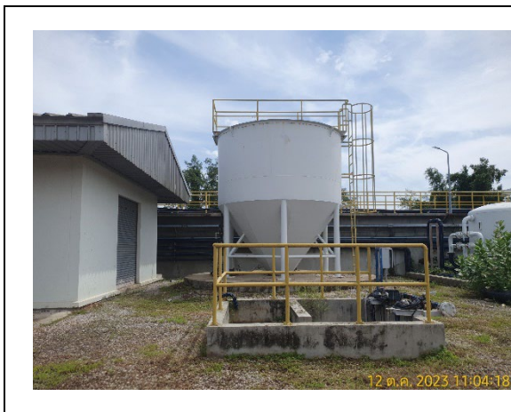
รูปถ่ายที่ 3.2-11 : ถังพักน้ำทิ้ง RO Reject
