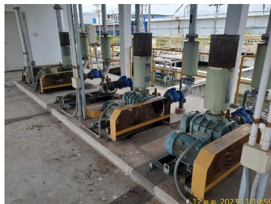
รูปถ่ายที่ 3.2-3 : อุปกรณ์ยึดติดกับคอนกรีตเพื่อ ลดเสียงดัง
