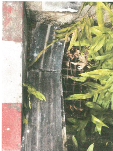
รูปภาพที่ 2.6 ตะแกรงดักมูลฝอย บริเวณจุดระบายน้ำออก
