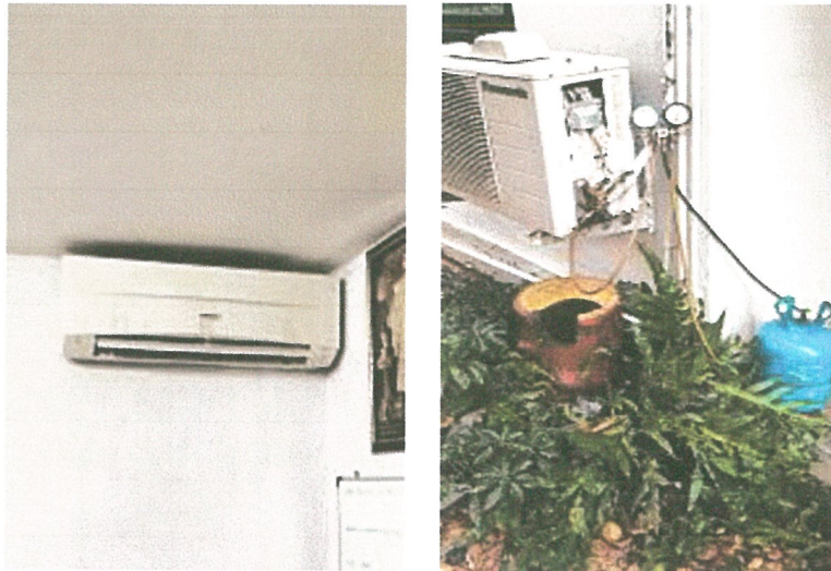
รูปภาพที่ 2.40 ล้างทำความสะอาดเครื่องปรับอากาศ
