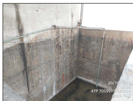
ภาพที่ 16 บ่อพักน้ำทิ้งขนาด 100 ลูกบาศก์เมตร
