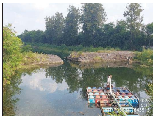
ภาพที่ 20 บ่อดักตะกอน ขนาด 3,000 ลูกบาศก์เมตร
