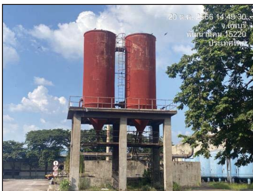
ภาพที่ 27 ถังทำตะกอนขึ้น
