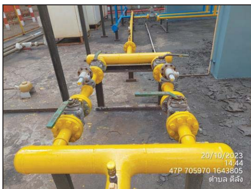
ภาพที่ 41 Safety Valve (LPG) เพื่อระบายความดัน
