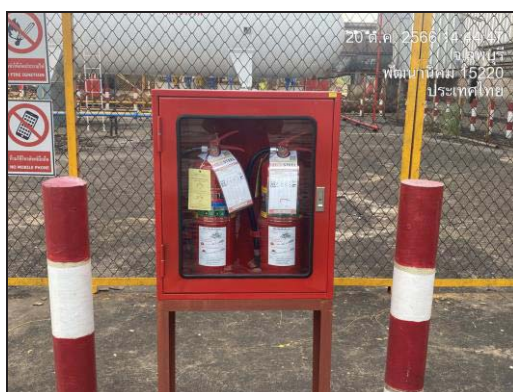
ภาพที่ 45 การติดตั้งอุปกรณ์ดับเพลิง
