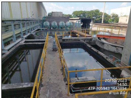
ภาพที่ 17 ระบบดักน้ำมันและกรองทราย
