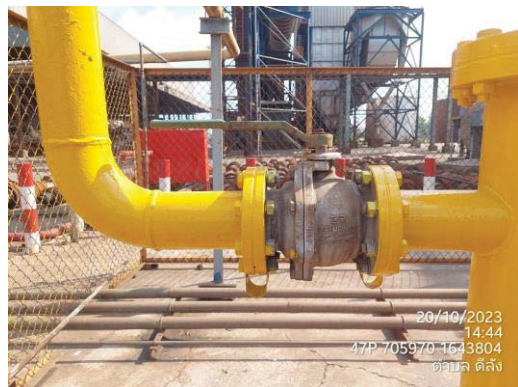
ภาพที่ 41 Safety Valve (LPG) (ต่อ) เพื่อระบายความดัน
