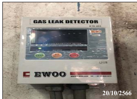
ภาพที่ 44 อุปกรณ์ตรวจวัดก๊าซรั่วไหล (Gas Detector)
