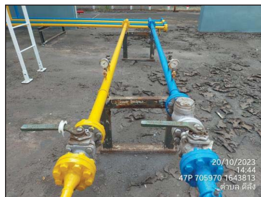
ภาพที่ 41 Safety Valve (LPG) เพื่อระบายความดัน
