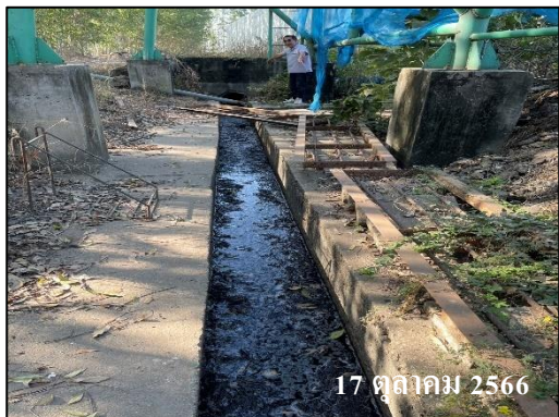
ภาพที่ 21 ชุดลอกรางระบายน้ำรอบลานกองเก็บกากตะกอนหม้อกรองและลานกองเศษอ้อย
