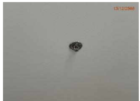
หัวฉีดน้ำ (Sprinkler)
