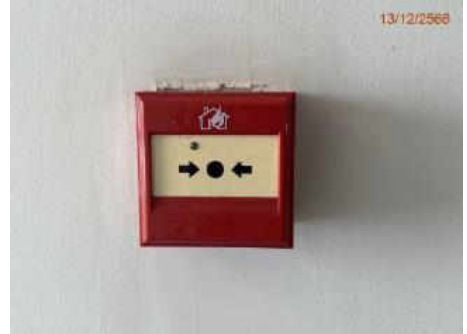
อุปกรณ์แจ้งเหตุเพลิงไหม้ด้วยมือ (Manual Station)
