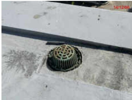
หัวรับน้ำฝน (Rain Drain)
