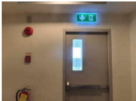
ป้ายแสดงทางหนีไฟ (Fire Exit Light) และประตูหนีไฟ
