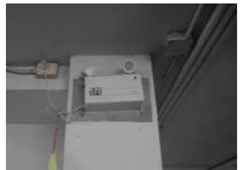
ไฟส่องสว่างฉุกเฉิน (Emergency Light)
