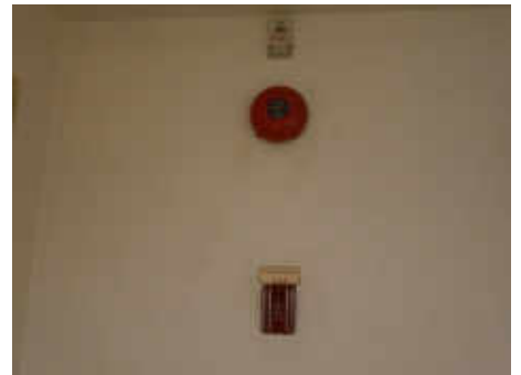
อุปกรณ์แจ้งเหตุเพลิงไหม้ด้วยมือ (Manual Station) และอุปกรณ์ส่งสัญญาณแบบกระดิ่ง (Alarm Bell)
