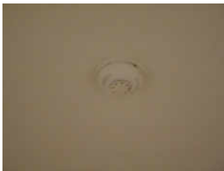
เครื่องตรวจจับความร้อน (Heat Detector)
