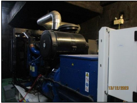
รูปที่ 24 เครื่องกำเนิดไฟฟ้าฉุกเฉิน (Generator) ขนาด 500 KVA จำนวน 1 เครื่อง
