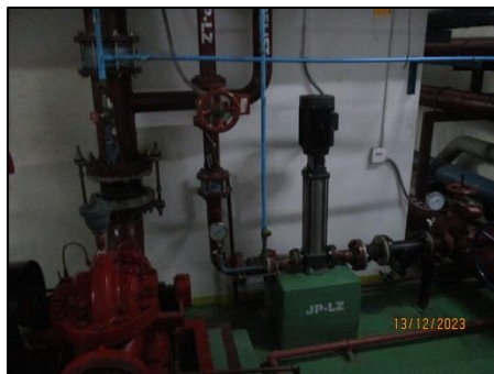
รูปที่ 27 เครื่องสูบน้ำดับเพลิง ชนิดเครื่องยนต์ดีเซล
