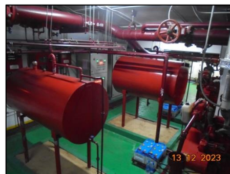
รูปที่ 28 ระบบท่ออื่น ใช้ท่ออื่นที่มีขนาดเส้นผ่านศูนย์กลาง 6 นิ้ว สำหรับพื้นที่ Low Zone และ High Zone
