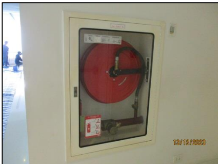
รูปที่ 29 ตู้เก็บสายฉีดน้ำดับเพลิงพร้อมอุปกรณ์ (FHC)
