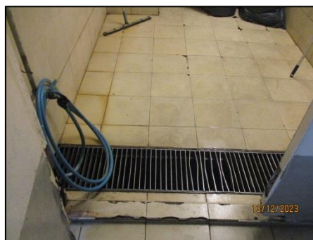
รูปที่ 22 รางระบายน้ำรวบรวมน้ำจากการล้างห้องพักมูลฝอยเข้าสู่ระบบบำบัดน้ำเสีย
