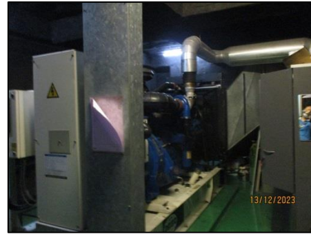
รูปที่ 24 เครื่องกำเนิดไฟฟ้าฉุกเฉิน (Generator) ขนาด 500 KVA จำนวน 1 เครื่อง
