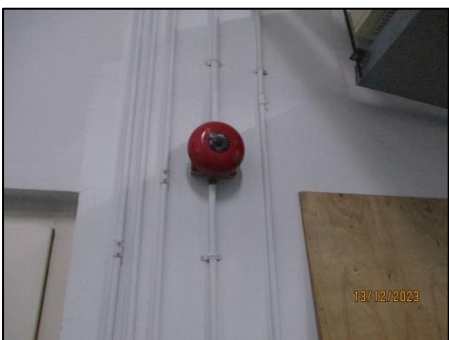
รูปที่ 38 Fire Alarm Bell และ Fire Alarm Manual Station ภายในอาคารชุดกึ่งหลังสวน
