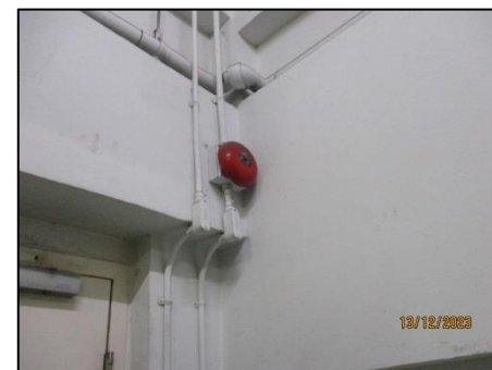
รูปที่ 38 Fire Alarm Bell และ Fire Alarm Manual Station ภายในอาคารชุดกึ่งหลังสวน
