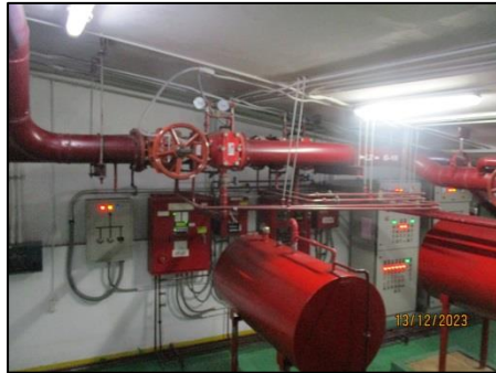
รูปที่ 27 เครื่องสูบน้ำดับเพลิง ชนิดเครื่องยนต์ดีเซล
