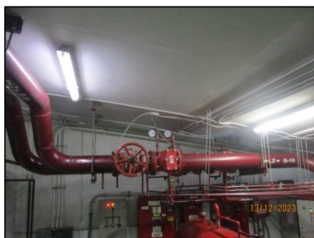
รูปที่ 28 ระบบท่ออื่น ใช้ท่ออื่นที่มีขนาดเส้นผ่านศูนย์กลาง 6 นิ้ว สำหรับพื้นที่ Low Zone และ High Zone
