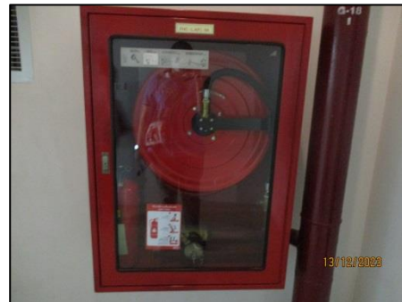
รูปที่ 29 ตู้เก็บสายฉีดน้ำดับเพลิงพร้อมอุปกรณ์ (FHC)
