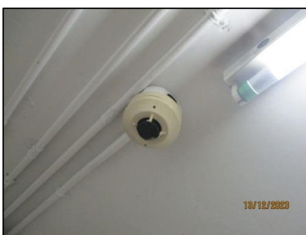
รูปที่ 37 Heat Detector ภายในอาคารชุดคิวหลังสวน
