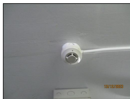
รูปที่ 37 Heat Detector ภายในอาคารชุดคิวหลังสวน
