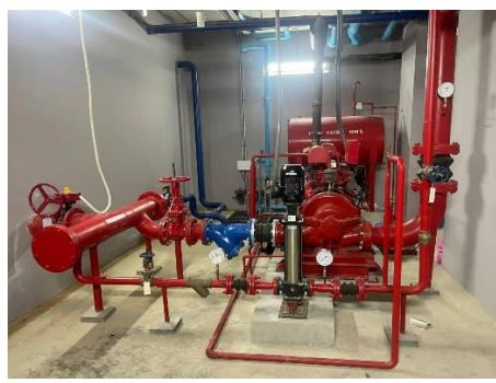
ภาพที่ 2-49 เครื่องสูบน้ำดับเพลิง (Fire Pump)
