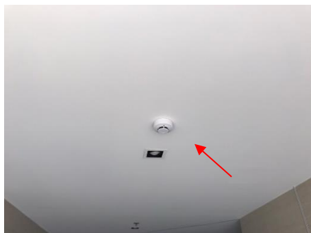
ภาพที่ 2-57 เครื่องตรวจจับความร้อน (Heat Detector)
