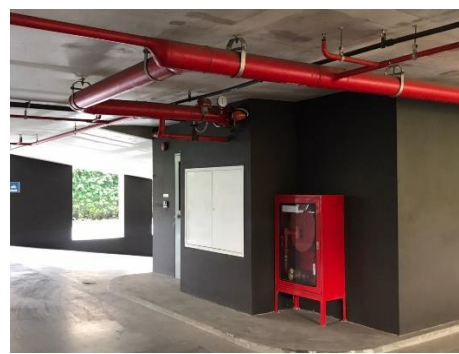
ภาพที่ 2-52 ตู้เก็บสายต่อน้ำดับเพลิงพร้อมอุปกรณ์ (FHC)
