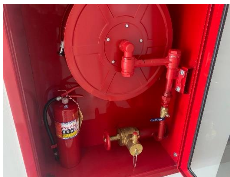
ภาพที่ 2-52 ตู้เก็บสายต่อน้ำดับเพลิงพร้อมอุปกรณ์ (FHC)
