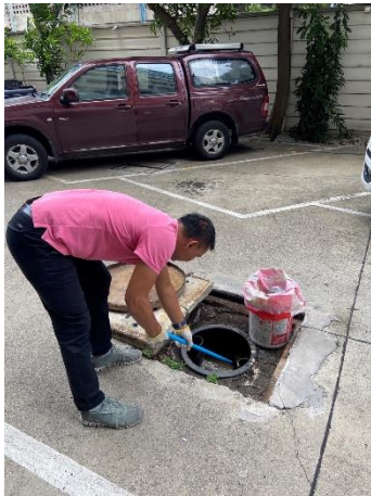
ภาพที่ 2-4 ตักกากตะกอนออกจากถังตะกอนเป็นประจำทุกสัปดาห์
