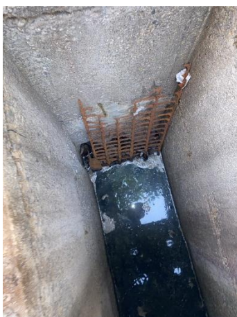
ภาพที่ 2-6 ติดตั้งตะแกรงดักขยะบริเวณบ่อพักน้ำบ่อสุดท้าย
