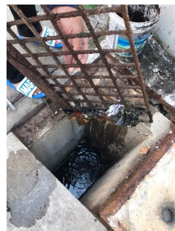
ภาพที่ 2-6 ติดตั้งตะแกรงดักขยะบริเวณบ่อพักน้ำบ่อสุดท้าย
