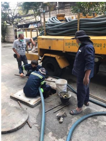
ภาพที่ 2-3 สำนักงานเขตธนบุรีเข้ามาสูบน้ำถ่ายตะกอน
