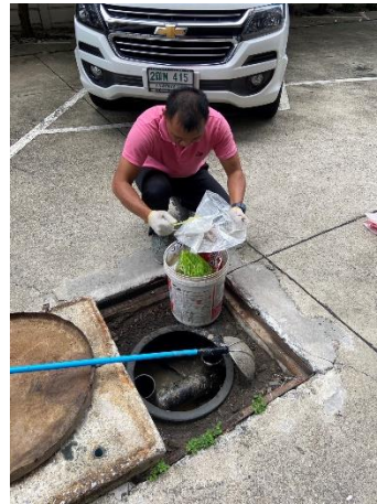
ภาพที่ 2-4 ตักกากตะกอนออกจากถังตะกอนเป็นประจำทุกสัปดาห์
