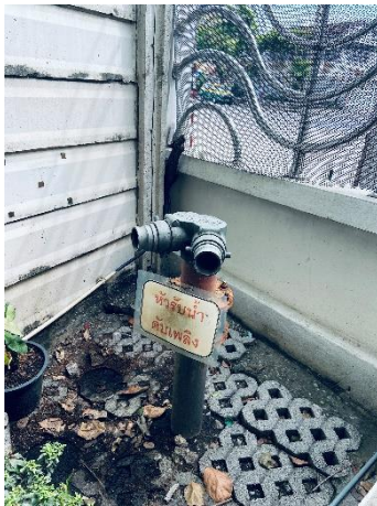
ภาพที่ 2-16 ติดตั้งหัวรับน้ำดับเพลิงภายนอกอาคาร
