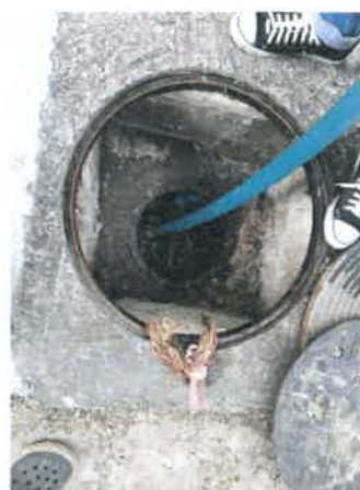
รูปที่ 2-16 แสดงช่างประจำโครงการดูแลระบบบำบัดน้ำเสีย พร้อมทั้งดำเนินการสูบน้ำเสียออกจาก จากระบบบำบัดน้ำเสียไปกำจัด
