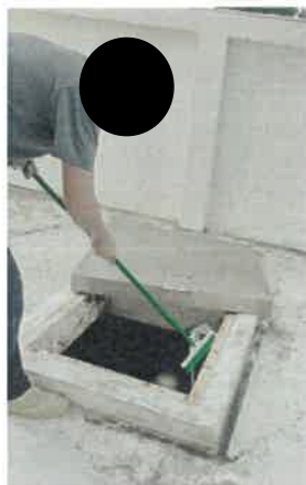
รูปที่ 2-14 แสดงเจ้าหน้าที่ตรวจสอบโครงสร้างถังเก็บน้ำใต้ดินและชั้นดาดฟ้า พร้อมทั้งทำความสะอาดถังเก็บน้ำใต้ดินและชั้นดาดฟ้า
