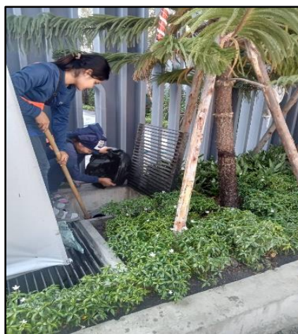
รูปที่ 58 คนงานเก็บกวาดขยะออกจากบ่อตัดตะกอน
