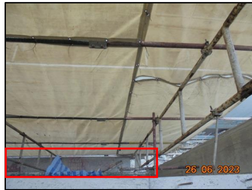
รูปที่ 83 แผงกันกันวัสดุตกหล่น
