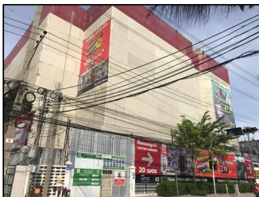
รูปที่ 84 การใช้ผ้าใบเพื่อป้องกันการกระเด็นหรือตกหล่นวัสดุ
