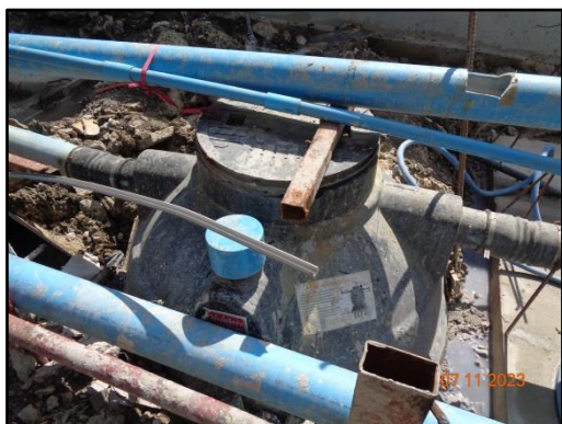
รูปที่ 45 ระบบบำบัดน้ำเสียสำเร็จรูปในพื้นที่ก่อสร้าง
