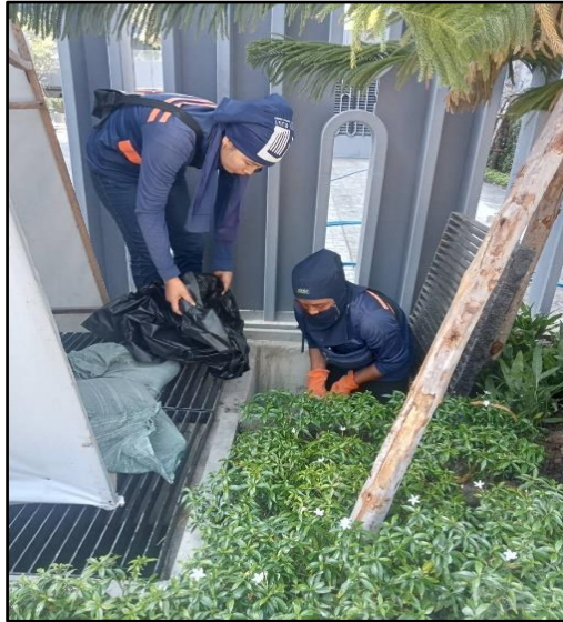
รูปที่ 9 ป่อดักตะกอน
