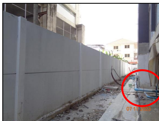
รูปที่ 7 วางระบายน้ำชั่วคราว และท่อระบายน้ำรอบพื้นที่โครงการ
