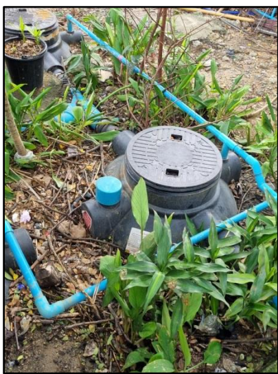
รูปที่ 46 ระบบบำบัดน้ำเสียสำเร็จรูปในพื้นที่บ้านพักคนงาน
