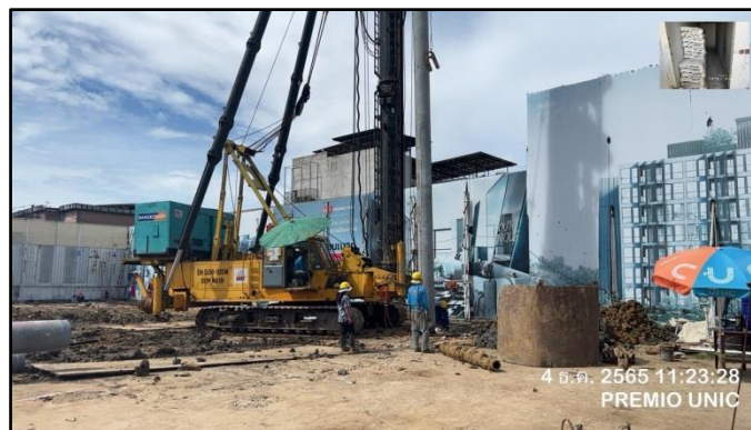
รูปที่ 39 เสาเข็มเจาะ โดยมีการติดตั้งด้วยวิธีเจาะกด (JACK IN PILE SYSTEM)
