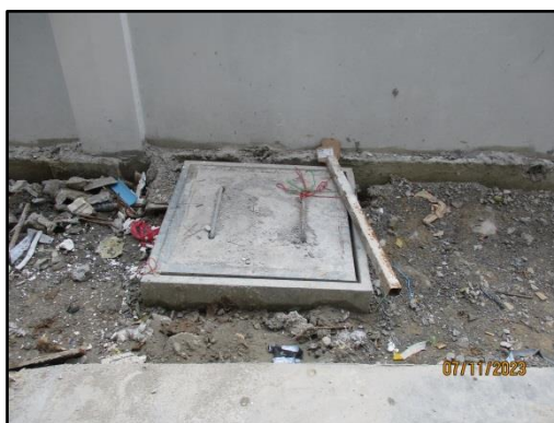
รูปที่ 8 ป่อพักน้ำทิ้ง
