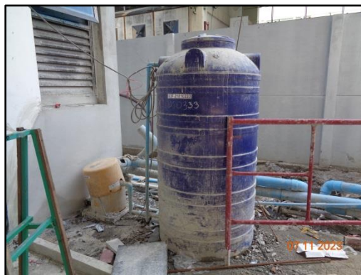
รูปที่ 47 ถังเก็บน้ำสำรองสำหรับในพื้นที่ก่อสร้าง
