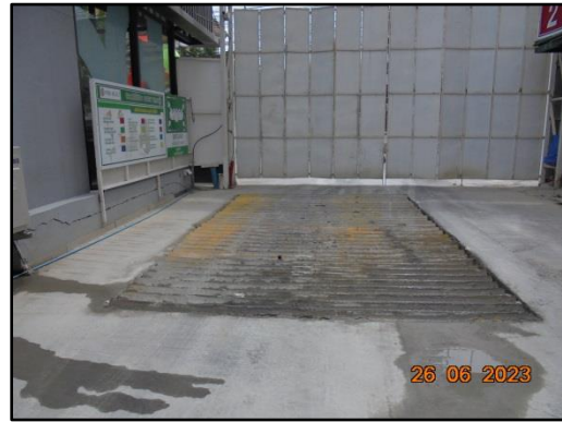
รูปที่ 51 พื้นที่ล้างล้อรถยนต์ของโครงการ
