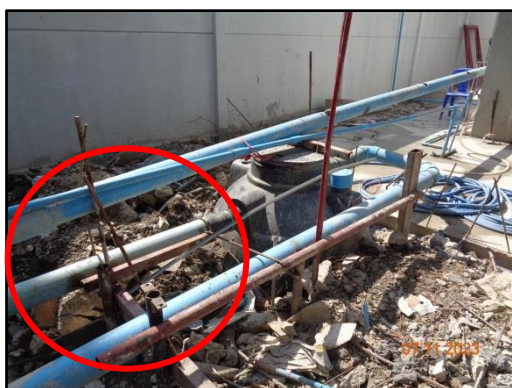
รูปที่ 7 วางระบายน้ำชั่วคราว และท่อระบายน้ำรอบพื้นที่โครงการ
