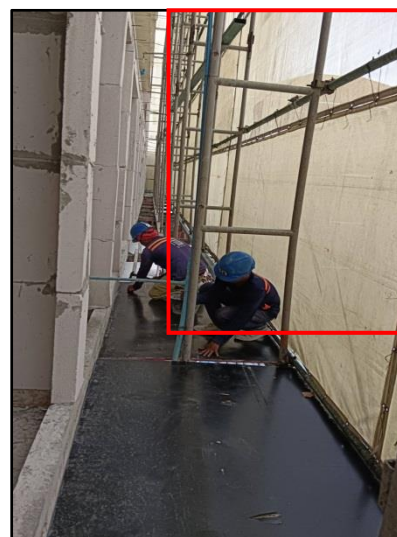
รูปที่ 84 การใช้ผ้าใบเพื่อป้องกันการกระเด็นหรือตกหล่นวัสดุ
