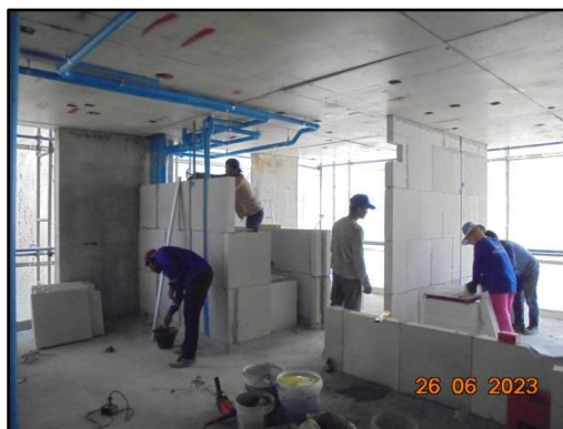
รูปที่ 72 วัสดุก่อสร้างสำเร็จรูป หรือกึ่งสำเร็จรูป
