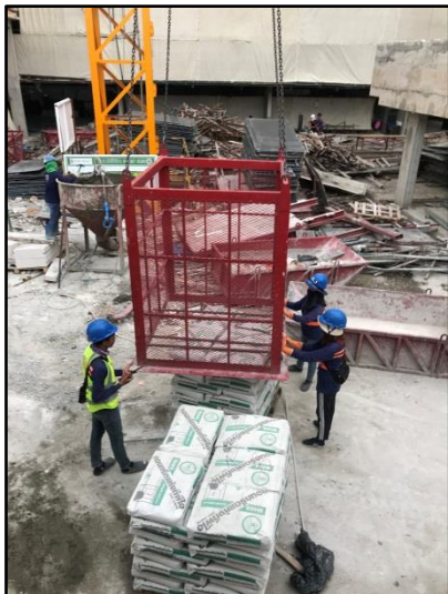
รูปที่ 90 เลือกใช้เครื่องมือและวิธีลำเลียงที่เหมาะสมและปลอดภัย
