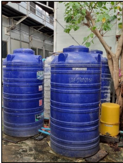
รูปที่ 48 ถังเก็บน้ำสำรองสำหรับในบ้านพักคนงาน
