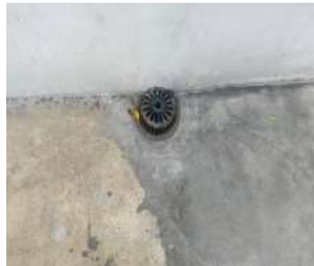
รูปที่ 2-16 ตะแกรงดักขยะ
