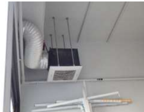
รูปที่ 2-24 ช่องดูดอากาศภายในห้องพักมูลฝอย
