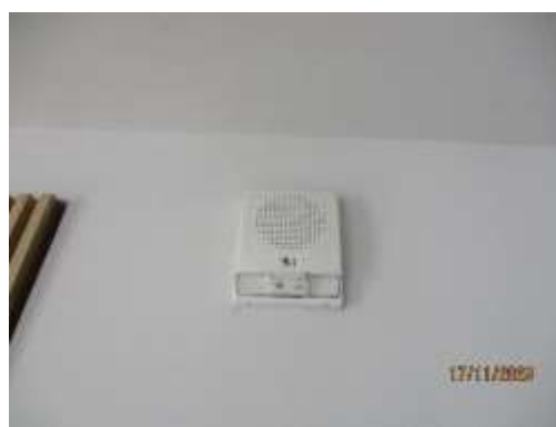
อุปกรณ์ส่งเสียงแบบกริ่งสัญญาณ
