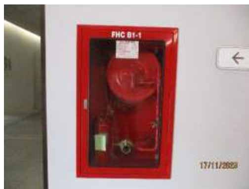
รูปที่ 2-30 ตู้เก็บสายฉีดน้ำดับเพลิงแต่ละชั้น
