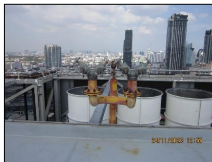
หัวฉีดน้ำหล่ออาคาร (Roof Manifold)
