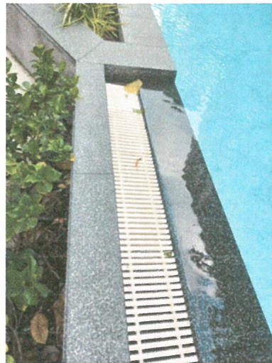
รูปภาพที่ 2.46 รางระบายน้ำล้อมรอบสระว่ายน้ำ
