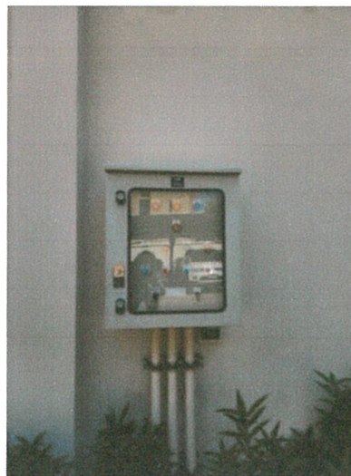
รูปภาพที่ 2.20 ตู้ควบคุมการทำงานของระบบบำบัดน้ำเสีย
