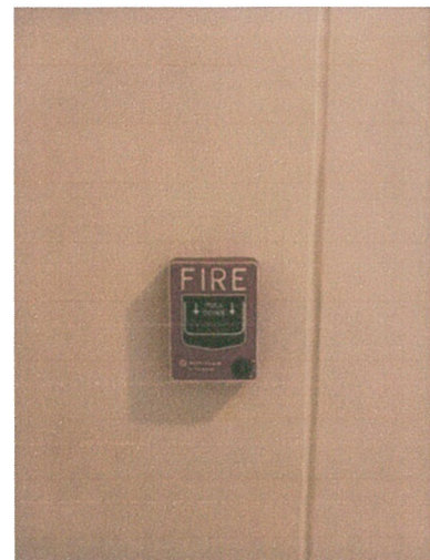
อุปกรณ์แจ้งเตือนเพลิงไหม้แบบมือดึง
