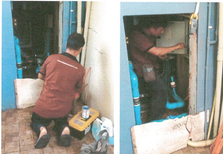
รูปภาพที่ 2.26 การตรวจสอบระบบบำบัดน้ำเสีย
