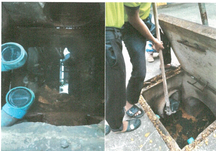
รูปภาพที่ 2.27 การขุดลอกตะกอน
