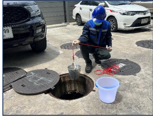
รูปที่ 3.4-6 การตรวจวัดคุณภาพน้ำทิ้ง บริเวณที่ตรวจวัด : น้ำทิ้งที่ผ่านการบำบัดจากระบบบำบัดน้ำเสีย อาคาร B
