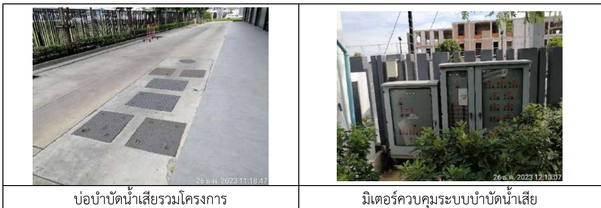
รูปที่ 2-5 การดูแลตรวจสอบประสิทธิภาพของระบบของบำบัดน้ำเสียของโครงการ
