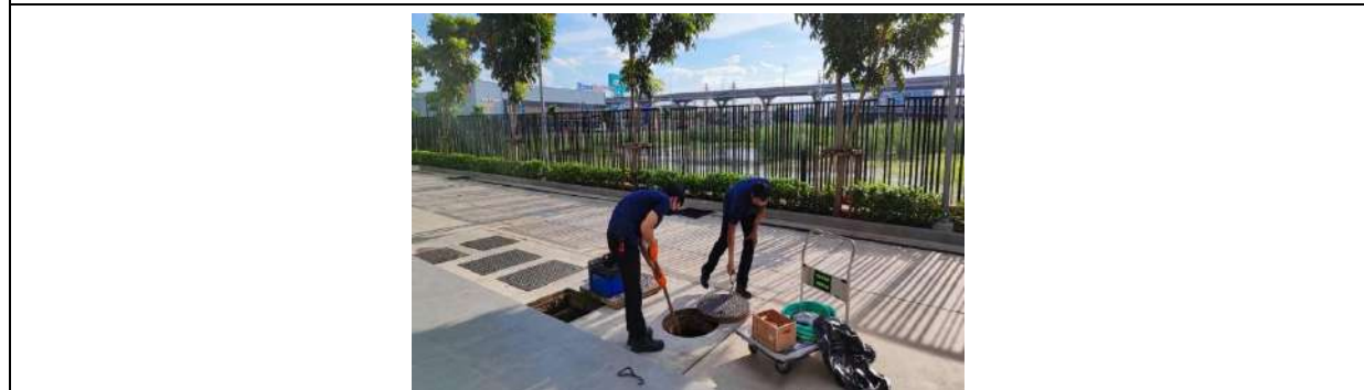
การกำจัดกากไขมันในระบบบำบัดน้ำเสียของโครงการ
