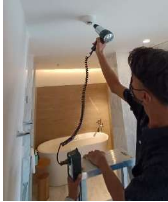
รูปที่ 2-22 การตรวจสอบระบบป้องกันและระงับอัคคีภัย
