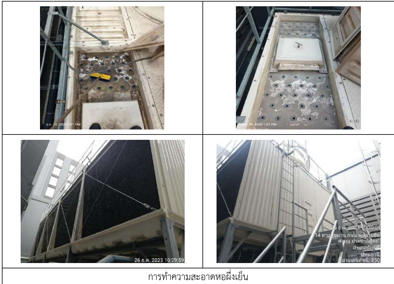
รูปที่ 2-28 การตรวจสอบและทำความสะอาดระบบปรับอากาศ (ต่อ)
