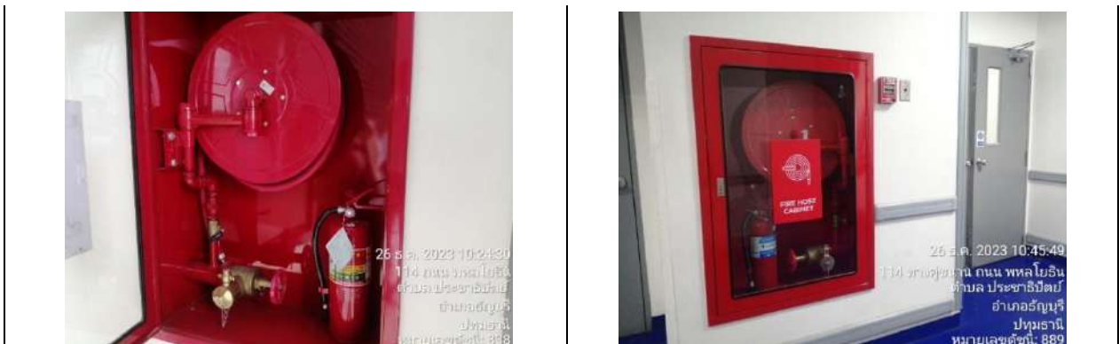
ตู้เก็บสายฉีดน้ำดับเพลิง
