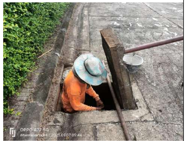
รูปที่ 2-3 การขุดลอกท่อระบายน้ำและกำจัดขยะบริเวณตะแกรงดักขยะ
