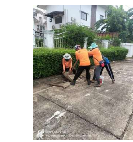
รูปที่ 2-3 การขุดลอกท่อระบายน้ำและกำจัดขยะบริเวณตะแกรงดักขยะ
