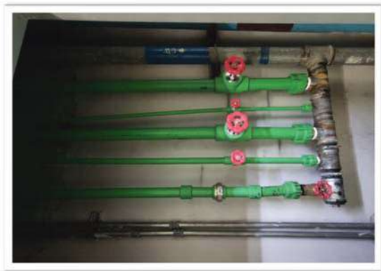
ภาพเปรียบเทียบการ เปลี่ยนท่อส่งน้ำประปาที่รั่ว จากท่อเหล็กเป็น PPR
