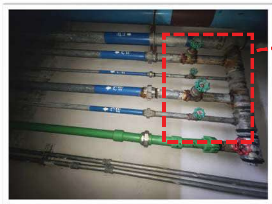
ภาพเปรียบเทียบการ เปลี่ยนท่อส่งน้ำประปาที่รั่ว จากท่อเหล็กเป็น PPR
