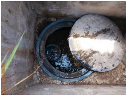
บ่อพักก่อนเข้าสู่ระบบบำบัดน้ำเสียของอาคารที่พักผู้โดยสาร
