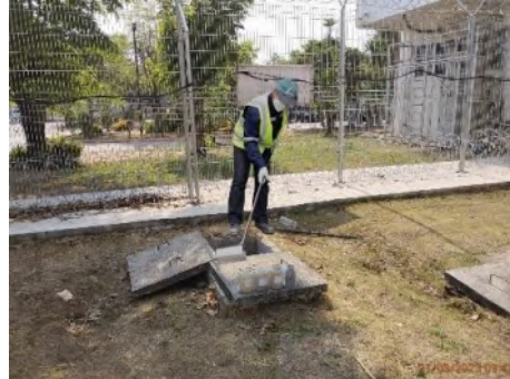
บ่อกักก่อนเข้าสู่ระบบบำบัดน้ำเสียของอาคารที่พักผู้โดยสาร
