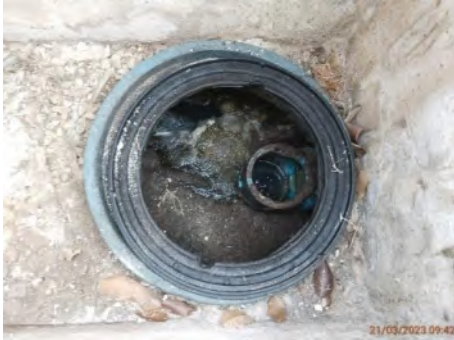
บ่อกักก่อนเข้าสู่ระบบบำบัดน้ำเสียของอาคารที่พักผู้โดยสาร
