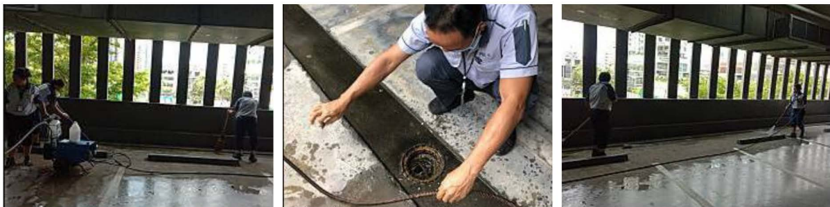
ภาพที่ 3-2 ตรวจสอบและขุดลอกรางระบายน้ำ
