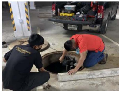
ภาพที่ 2-8 ตรวจสอบบำรุงรักษาระบบบำบัดน้ำเสีย
