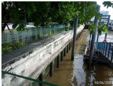
ภาพที่ 2-3 ผนังกำแพงกันน้ำกัดเซาะริมแม่น้ำเจ้าพระยา
