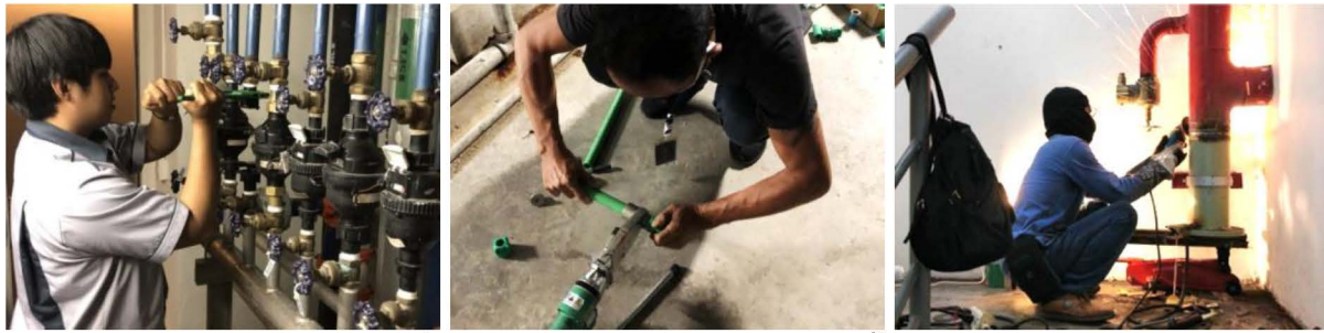
ภาพที่ 2-11 ช่างอาคารเชื่อมแซมระบบท่อน้ำประปา
