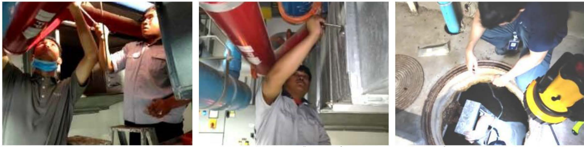
ภาพที่ 3-1 ตรวจสอบการทำงานปั๊มสูบน้ำและซ่อมแซมท่อน้ำ
