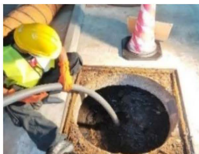
ภาพที่ 2-9 การสูบล้างปลักและดูดตะกอนบ่อบำบัดน้ำเสีย อาคาร A และ B
