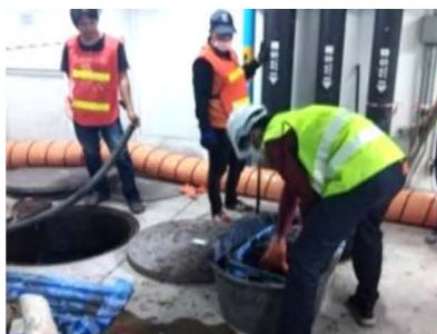
ภาพที่ 2-9 การสูบล้างปลักและดูดตะกอนบ่อบำบัดน้ำเสีย อาคาร A และ B
