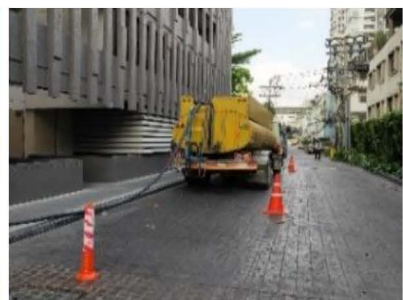
ภาพที่ 2-9 การสูบล้างปลักและดูดตะกอนบ่อบำบัดน้ำเสีย อาคาร A และ B
