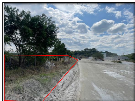
รูปที่ 2-42 คั่นดินสูงประมาณ 2 เมตร รอบบ่อดักตะกอน
