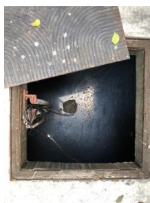
บ่อพักน้ำสุดท้ายก่อนระบายออกนอกโครงการ
