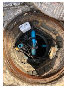
จุระบายน้ำออกจากระบบบำบัดน้ำเสีย A
