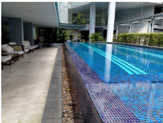
รูปที่ 2-22 รางระบายน้ำล้นสระว่ายน้ำ
