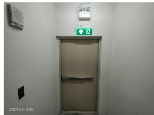
ประตูหนีไฟของอาคารทุกชั้นจะออกแบบให้มีก้านโยกที่สามารถเปิดย้อนเข้ามาในอาคารได้ (Re-Entry)
