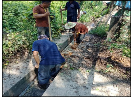
ภาพที่ 28 การขุดลอกรางระบายน้ำ
