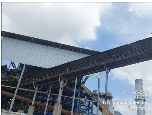
ภาพที่ 23 ระบบสายพานลำเลียงเข้าแบบระบบปิด
