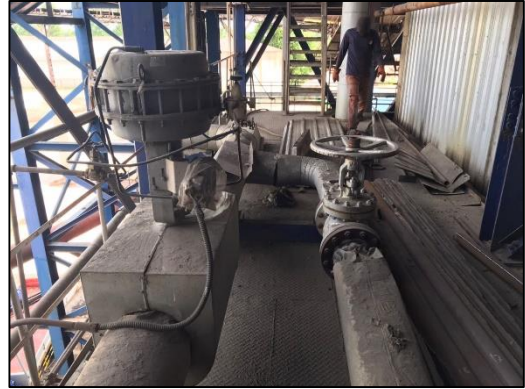
ภาพที่ 65 ติดตั้งวาล์วควบคุม (Control valve)
