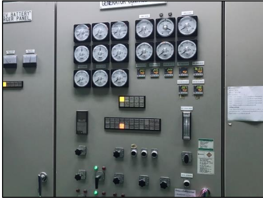
ภาพที่ 67 (ต่อ) ติดตั้งอุปกรณ์ป้องกันป้องกันกระแสเกิน (Over current relays), อุปกรณ์วัดอุณหภูมิของขดลวด, อุปกรณ์ป้องกันแรงดันไฟฟ้าสูงเกิน, อุปกรณ์ป้องกันกำลังไฟฟ้าย้อนกลับ, อุปกรณ์ป้องกันการรั่วไหลของแรงดันไฟฟ้า
