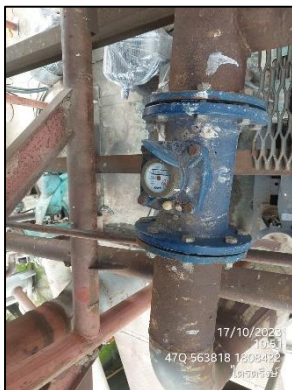
ภาพที่ 32 มาตรวัดน้ำบริเวณจุดสูบน้ำจากแม่น้ำปิง
