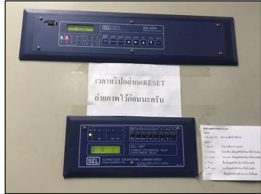
ภาพที่ 67 (ต่อ) ติดตั้งอุปกรณ์ป้องกันป้องกันกระแสเกิน (Over current relays), อุปกรณ์วัดอุณหภูมิของขดลวด, อุปกรณ์ป้องกันแรงดันไฟฟ้าสูงเกิน, อุปกรณ์ป้องกันกำลังไฟฟ้าย้อนกลับ, อุปกรณ์ป้องกันการรั่วไหลของแรงดันไฟฟ้า
