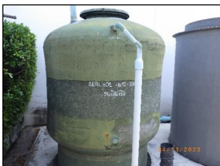
ถังบำบัดละอองน้ำ (Aerosol)
