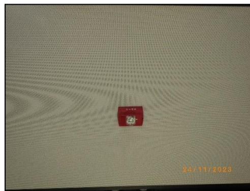
สัญญาณเตือนภัยด้วยเสียง (Fire Alarm Speaker)
