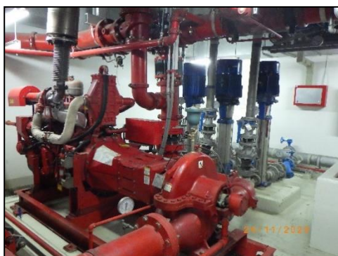
รูปที่ 2-4 ระบบสูบน้ำในอาคาร
