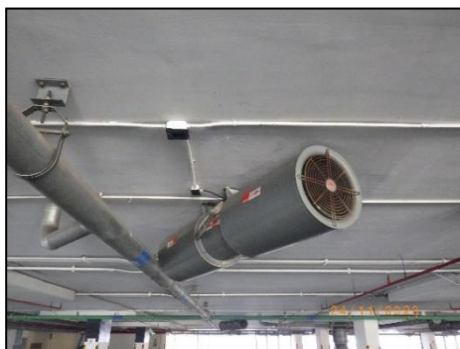
พัดลมระบายอากาศภายในอาคารจอดรถ
