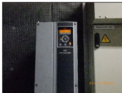
รูปที่ 2-25 อุปกรณ์ปรับความเร็วรอบมอเตอร์ VSD
