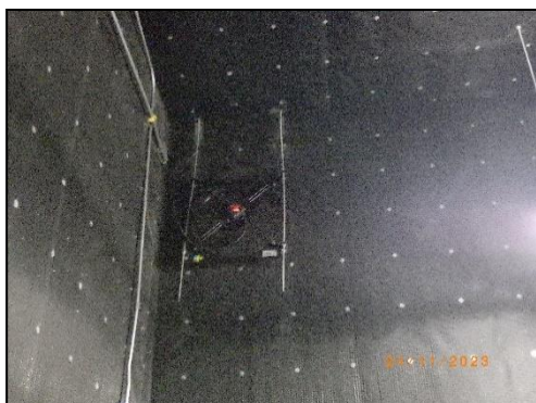
ติดตั้งตะแกรงกันเสียงบริเวณพัดลมระบายอากาศ
