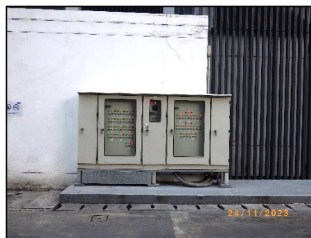
ระบบมิเตอร์ไฟฟ้าสำหรับระบบบำบัดน้ำเสีย
