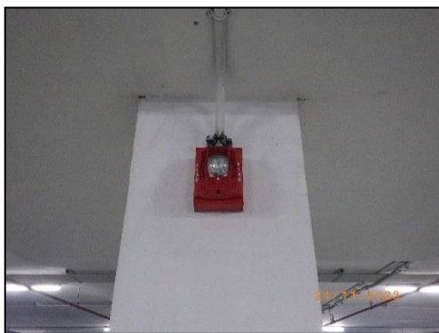
สัญญาณเตือนภัยด้วยเสียง (Fire Alarm Speaker)
