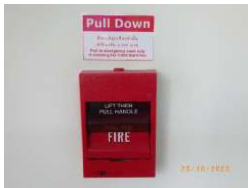
รูปที่ 2-50 Emergency Fire Button
