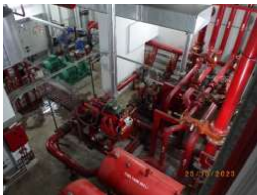
รูปที่ 2-53 Fire Pump System
