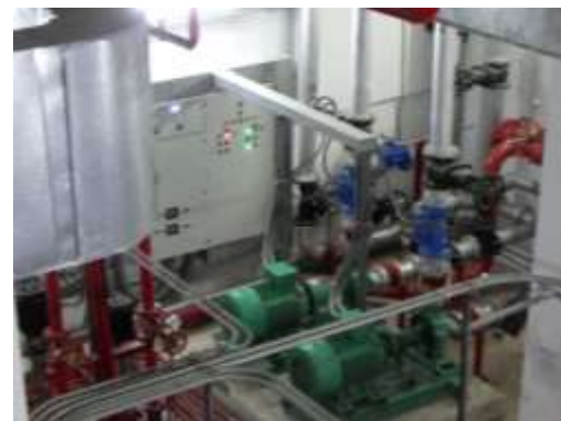
รูปที่ 2-53 Fire Pump System
