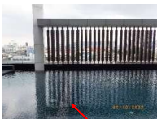
รูปที่ 2-13 การแบ่งสระว่ายน้ำส่วนตื้นและส่วนลึก โดยการเลือกใช้สีกระเบื้องและกันประภาตสระว่ายน้ำ
