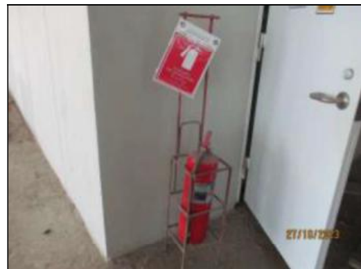
ภาพถ่ายที่ 2.2-26 เครื่องมือดับเพลิงขั้นต้นในพื้นที่ก่อสร้าง
