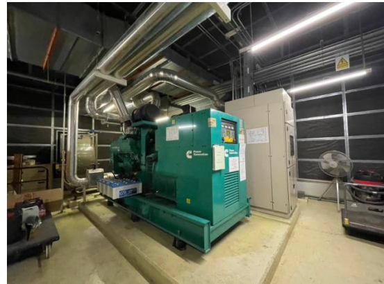
รูปที่ 2-20 เครื่องกำเนิดไฟฟ้าฉุกเฉิน ส่วนสำนักงาน
