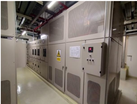
รูปที่ 2-19 หม้อแปลงไฟฟ้า ส่วนโรงแรม
