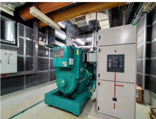
รูปที่ 2-21 เครื่องกำเนิดไฟฟ้าฉุกเฉิน ส่วนโรงแรม
