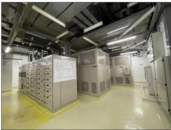
รูปที่ 1-7 หม้อแปลงไฟฟ้า ส่วนสำนักงาน
