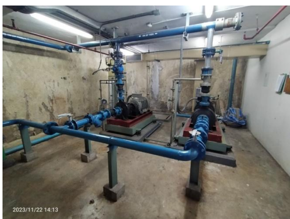
รูปที่ 2-34 ปั๊มน้ำใช้และน้ำดับเพลิง
