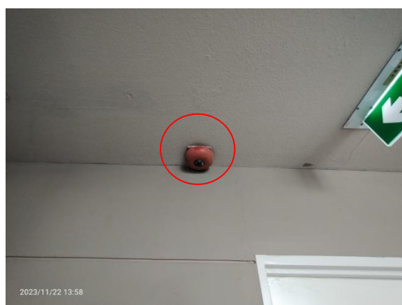
รูปที่ 2-19 อุปกรณ์แจ้งเหตุเพลิงไหม้
