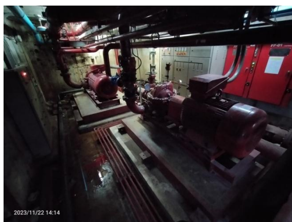
รูปที่ 2-34 ปั๊มน้ำใช้และน้ำดับเพลิง
