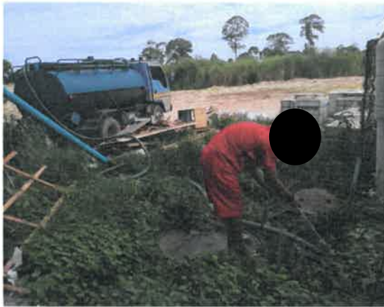
รูปที่ 2-20 แสดงห้องส้วมที่มีระบบบำบัดน้ำเสียสำเร็จรูปแบบถังเกรอะ-กรองไร้อากาศ และเจ้าหน้าที่สูบน้ำตะกอนบ่อเกรอะไปกำจัด
