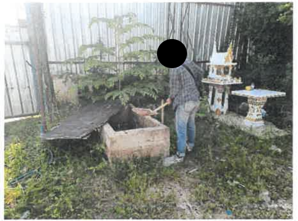
รูปที่ 2-26 แสดงการติดตั้งท่อระบายน้ำ สำหรับรวบรวมน้ำเข้าสู่บ่อพัก พร้อมทั้งจัดเจ้าหน้าที่ขุดลอก ตะกอนดินที่สะสมในบ่อพัก
