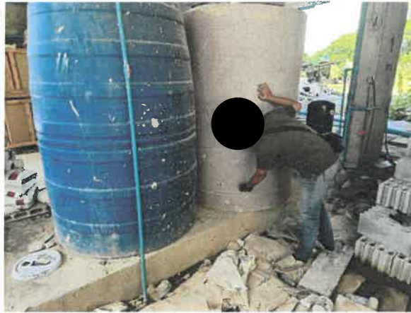
รูปที่ 2-22 แสดงเจ้าหน้าที่ตรวจสอบจุดรั่วซึมของถังเก็บน้ำสำรองภายในพื้นที่ก่อสร้าง
