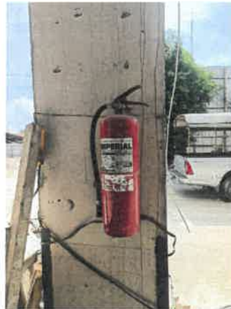
รูปที่ 2-32 แสดงถังดับเพลิงชนิดผงเคมีแห้งไว้บริเวณพื้นที่ก่อสร้าง
