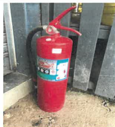
รูปที่ 2-45 แสดงถังดับเพลิงชนิดผงเคมีแห้ง ไว้บริเวณบ้านพักคนงาน
