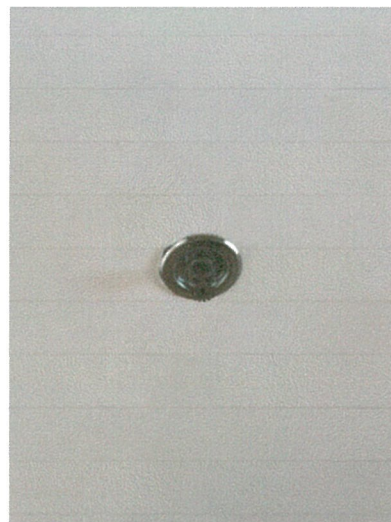
รูปภาพที่ 2.35 หัวกระจายน้ำดับเพลิงอัตโนมัติ
