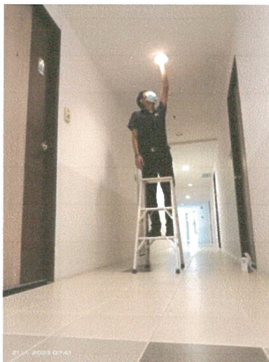
รูปภาพที่ 2.44 การตรวจสอบและซ่อมบำรุงไฟฟ้าส่องสว่าง
