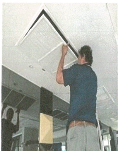
รูปภาพที่ 2.45 การทำความสะอาดเครื่องปรับอากาศ
