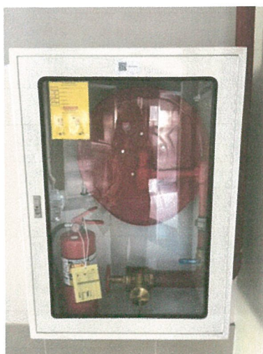
รูปภาพที่ 2.28 ถังดับเพลิงพร้อมสายฉีดน้ำ
