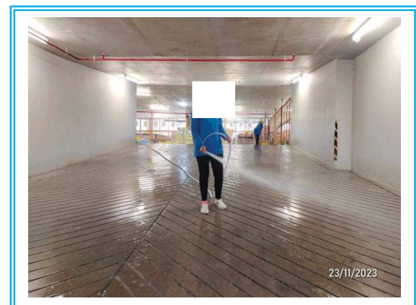
รูปที่ 3-12 ฉีดพรมน้ำบริเวณพื้นที่ก่อสร้าง
