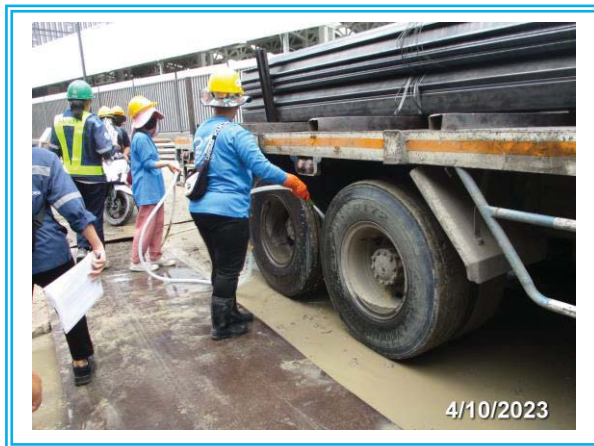
รูปที่ 3-9 ล้างล้อรถ
