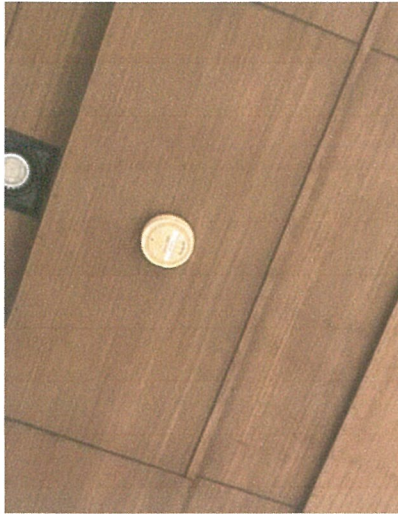
รูปภาพที่ 2.33 เครื่องตรวจจับควัน
