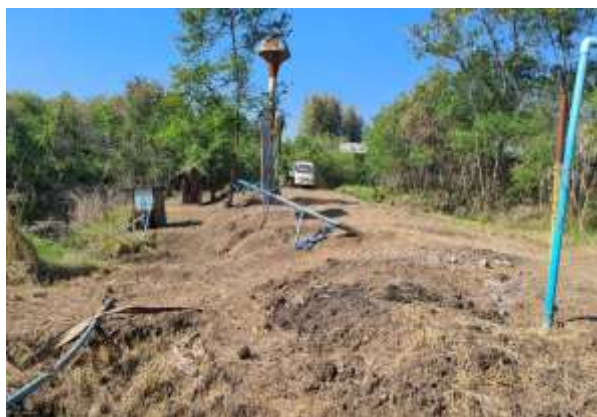
รูปที่ 29 ปรับเปลี่ยนพื้นที่และถมกลับขุมเหมือง ช่วงเดือนกุมภาพันธ์ 2566
