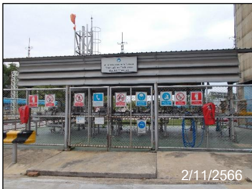
ภาพที่ 5 การติดตั้งป้ายเตือนอันตราย และป้ายเตือนความปลอดภัย
